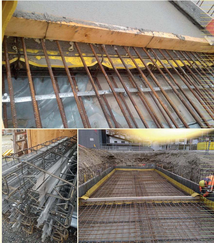
Das PERMATON Fugenabschalelement FAE ist ein zweiteiliges Abschalelement, das die einwandfreie Abschalung von horizontalen Plattenfugen (Bodenplatten und Decken) auf der Baustelle stark vereinfacht und eine sichere und wasserundurchlässige Ausbildung der Fuge sicherstellt.
