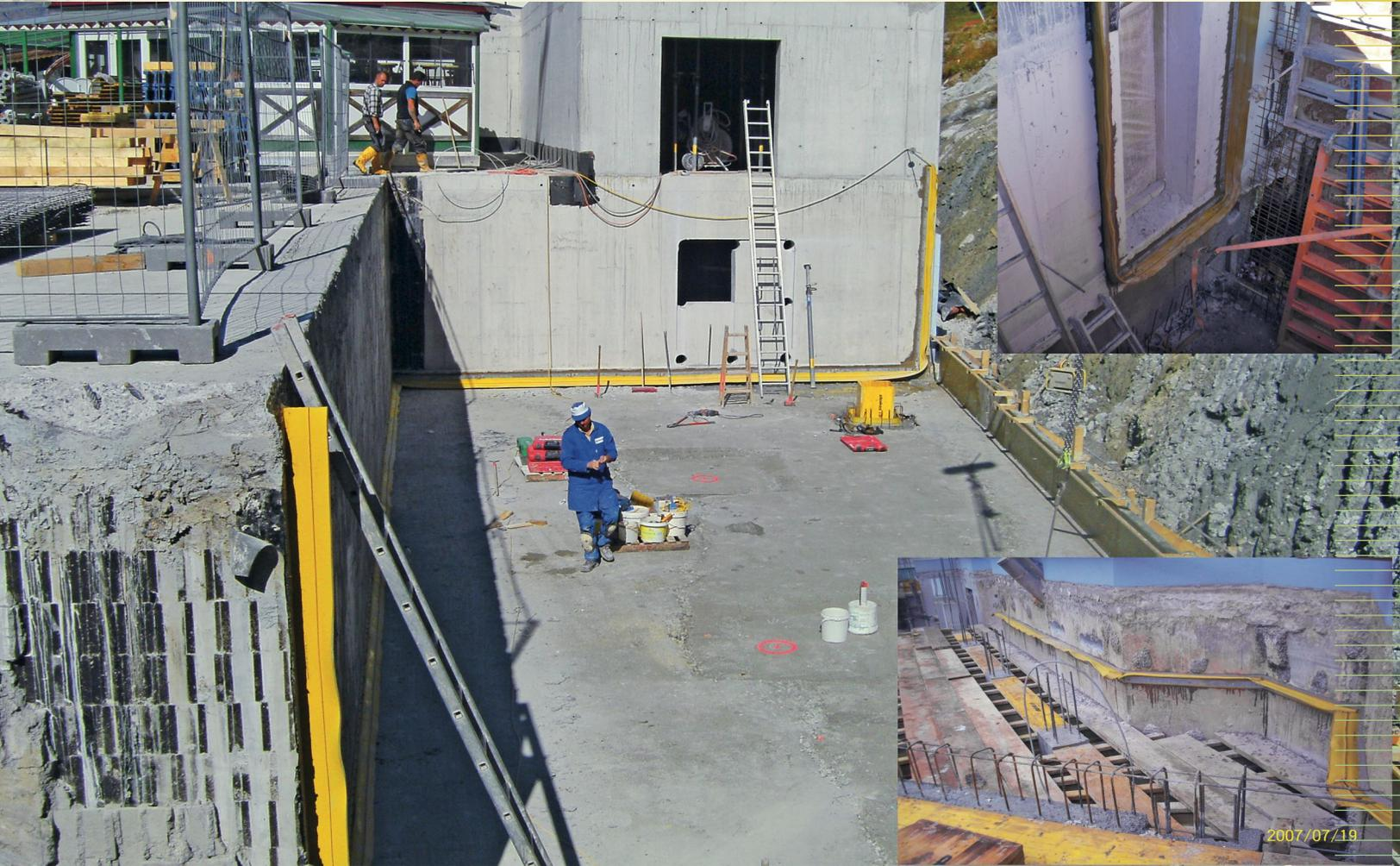
Das PERMATON-Klemmfugenband aus thermoplastischem Kunststoff (PVC-P) wird für unsere Klemmflanschkonstruktion zur wasserundurchlässigen Abdichtung von Anschlüssen an den Bestand (Alt-Neubau-Anschluss) verwendet. Der einbetonierte Fugenbandschenkel gewährleistet eine sehr gute Verankerung im Beton sowie eine sichere Abdichtung gegen drückendes Wasser.
